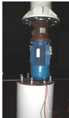
Монтаж мотор-редуктора в генераторный отсек
