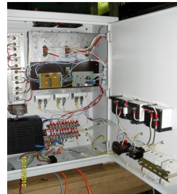
Общий вид и внутреннее устройств шкафа управления ВЭУ
